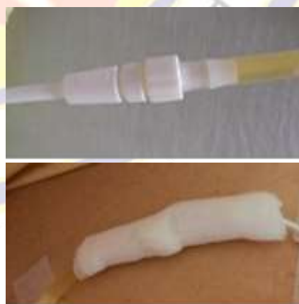
圖四 管路接頭包紮前與後
